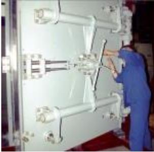
Дверь металлическая защитная герметичная предназначена для биологической защиты и герметизации проемов в помещениях АЭС.
